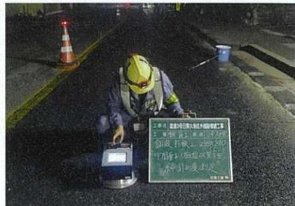
写真2 ■ 品質確保に向けた取り組み。アスファルト舗装の密度測定器を使用し、施工直後に締め固め密度を確認した
