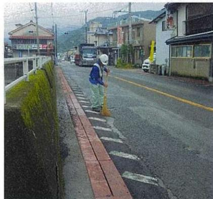
写真3 ■ 施工中の現場に削った合材が飛散するため、終日定期的に巡回して清掃。周囲に迷惑を掛けないよう留意した
